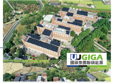
本校設置太陽能發電系統使用綠電 - 將四棟大樓樓頂採用台灣製造較環保的薄膜模組發電，善盡大學社會責任
