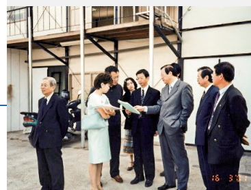
2 位創辦人視察建築工地
